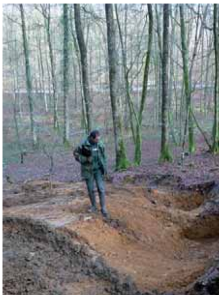
Bassins de décantation pour protéger la rivière en contrebas
