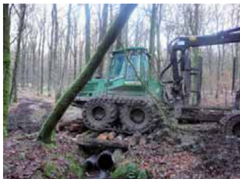
Passage d'un ruisseau avec un kit de franchissement PEHD complété de rondins
