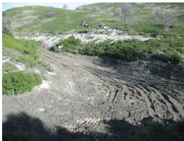
Bassin de stockage, dont on vient de vider les boues de décantation.
